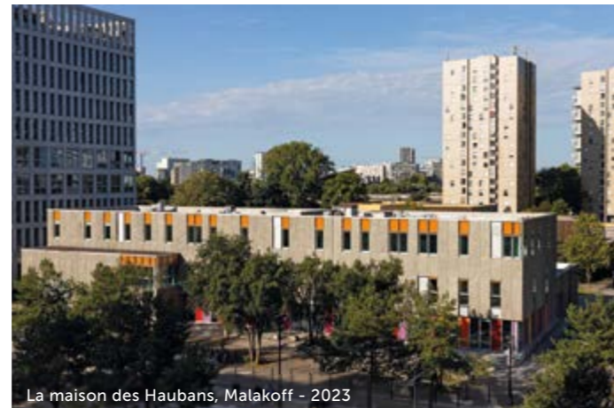
La maison des Haubans, Malakoff - 2023
